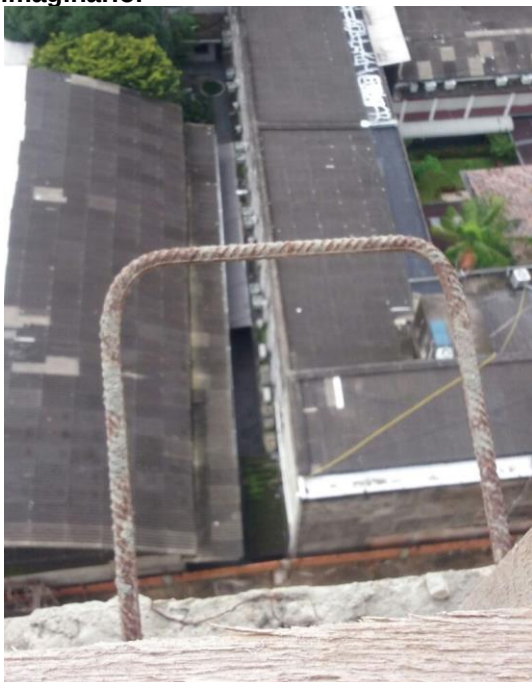
Figura 45: Gabarito em "U", locação do eixo imaginário.
