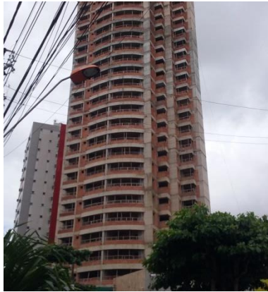
Figura 30: Vista frontal do Edifício A.
