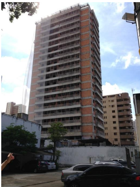
Figura 33: Vista lateral direita do Edifício B
