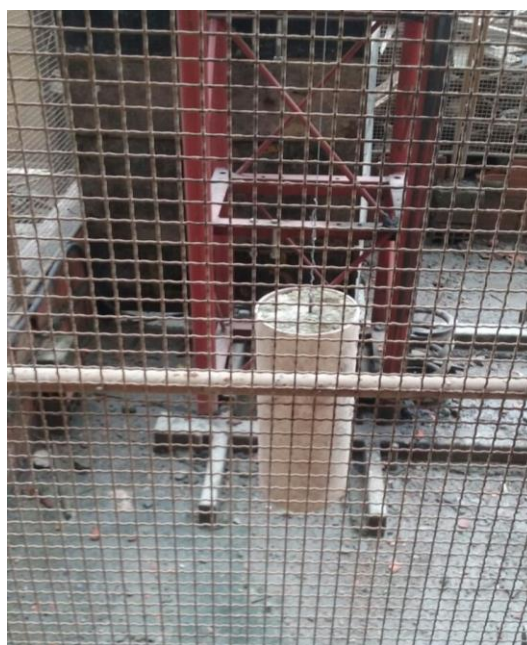
Figura 46: Pêndulo para estabilização da linha de prumada.
