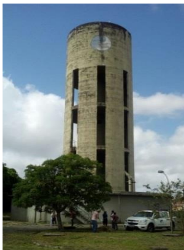
Figura 34. Vista do reservatório elevado.
