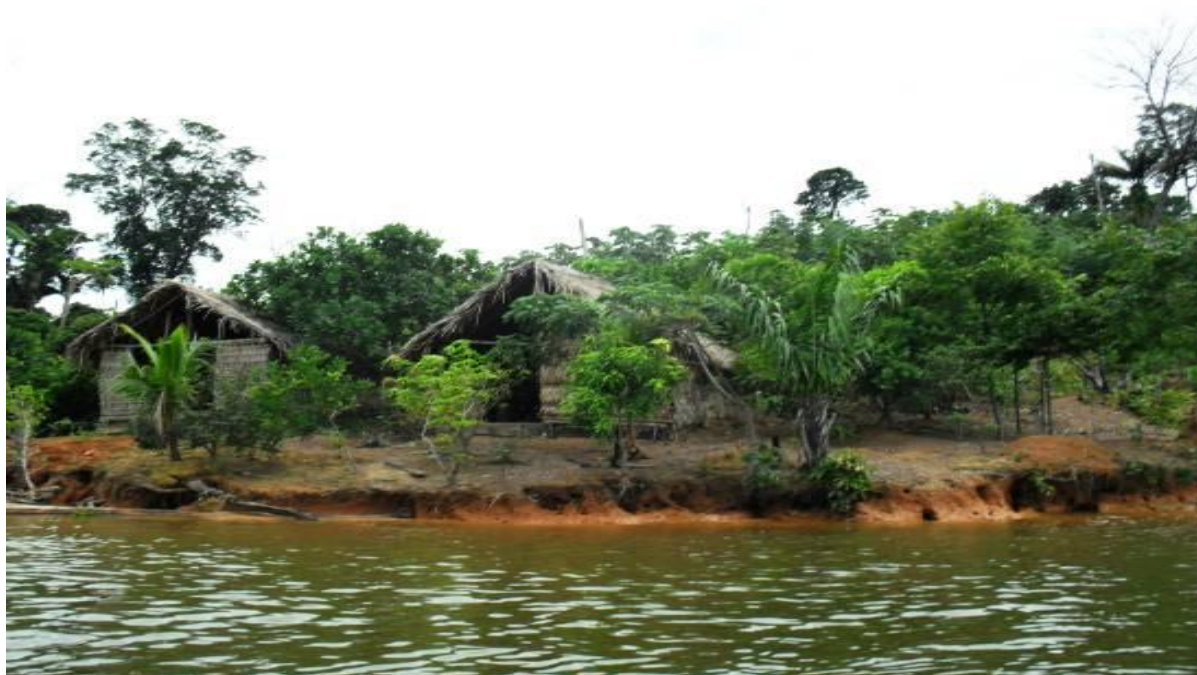
Figura 13 – Processo erosivo destruindo árvores frutíferas plantadas. Fonte: Arquivo SEMA, 2009.
