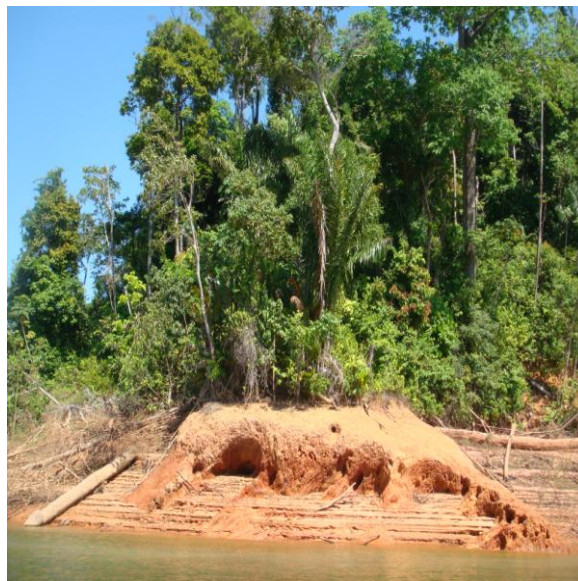
Figura 18 - Deslizamento e queda de árvores. Fonte. Acervo do autor, 2010.
