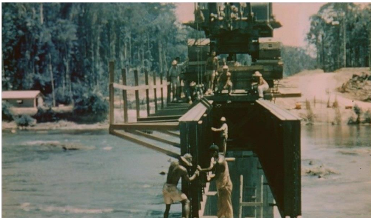
Fotografia 8: Construção da ponte férrea sobre o rio Amapari. Fonte: Dr. Antunes, 2012
