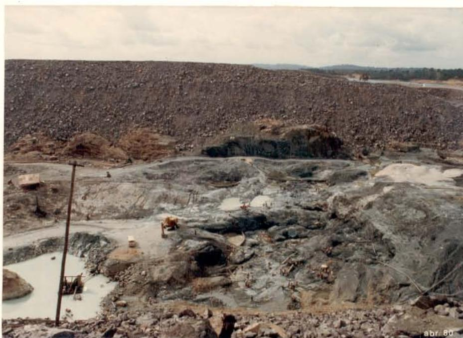
FIG. 30 - Vista geral do canal central da barragem de Tucuruí. Detalhe da falha de Tucuruí, ao fundo, com o contato entre as grauvacas da Formação Morrote e as ultramáficas da Formação Couto Magalhães.
