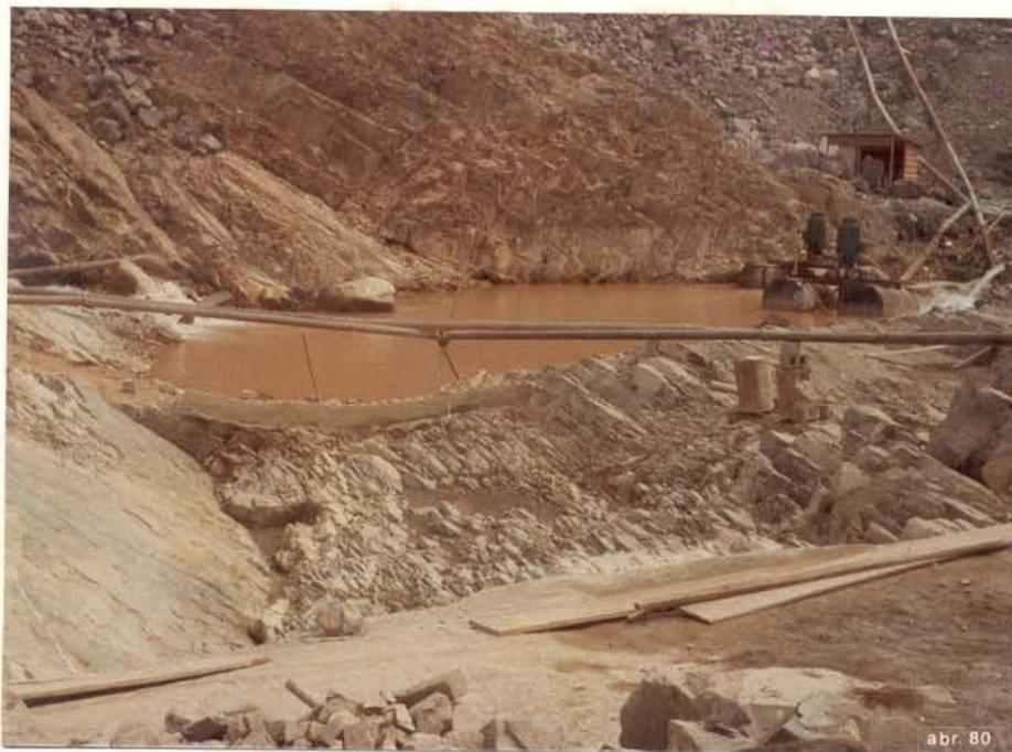
FIG. 42 - Grauvacas da Formação Morrote no canal central da barragem. Detalhe do intenso fraturamento nas proximidades do empurrão.
