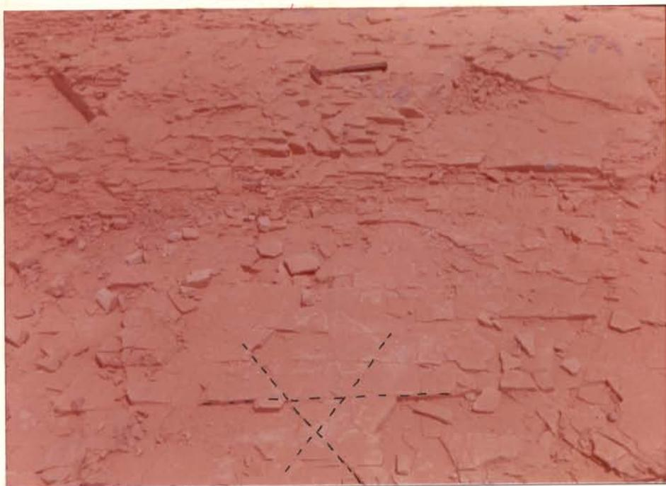
FIG. 8 - Detalhe do aspecto superficial das grau vacas da Formação Morrote no eixo da bar ragem de Tucuruí. Notam-se três famílias de juntas que se interceptam em padrão regular.
