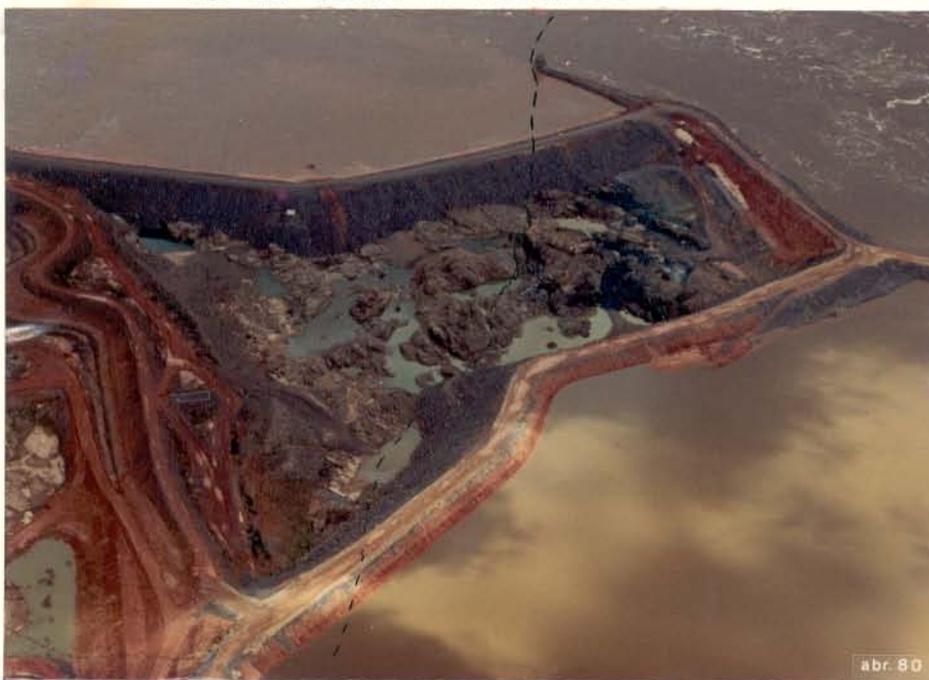
FIG. 2 - Vista aérea do canal central da barragem de Tucuruí. Em abril/80. Nota-se o leito do rio Tocantins ensecado, com a linha tracejada mostrando o traço aproximado da Falha de Tucuruí.
