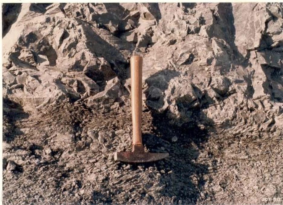
FIG. 12 - Detalhe da foliação cataclástica desenvolvida sobre rochas máficas intrusivas na Formação Couto Magalhães, no canal central da barragem,
