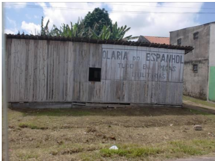
Figura 21: Olaria na rua Santa Isabel.
