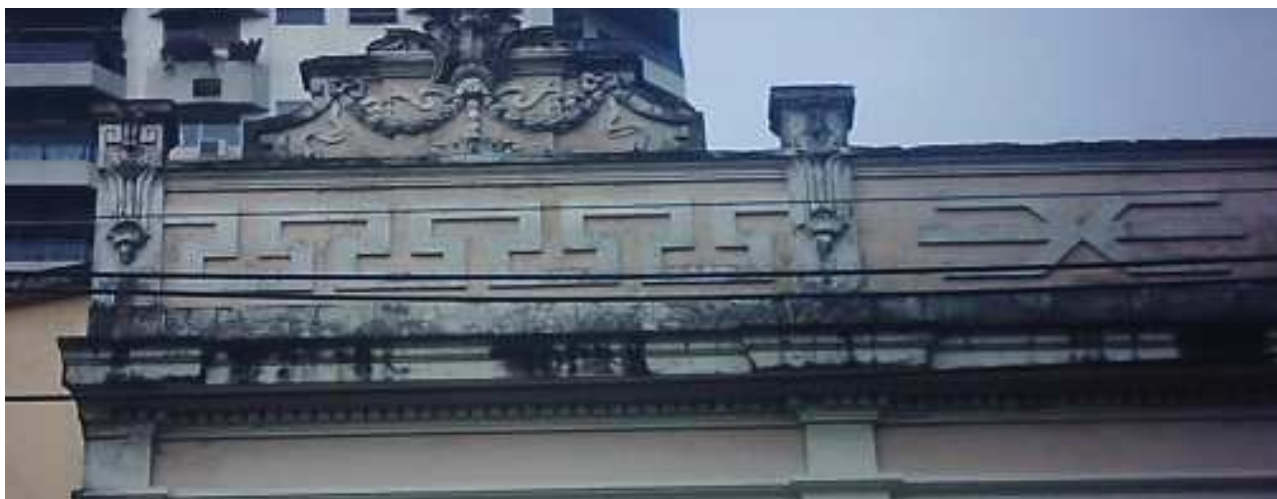
Figura 26: Detalhe platibanda da casa 1410 Fonte: Arquivo da autora
