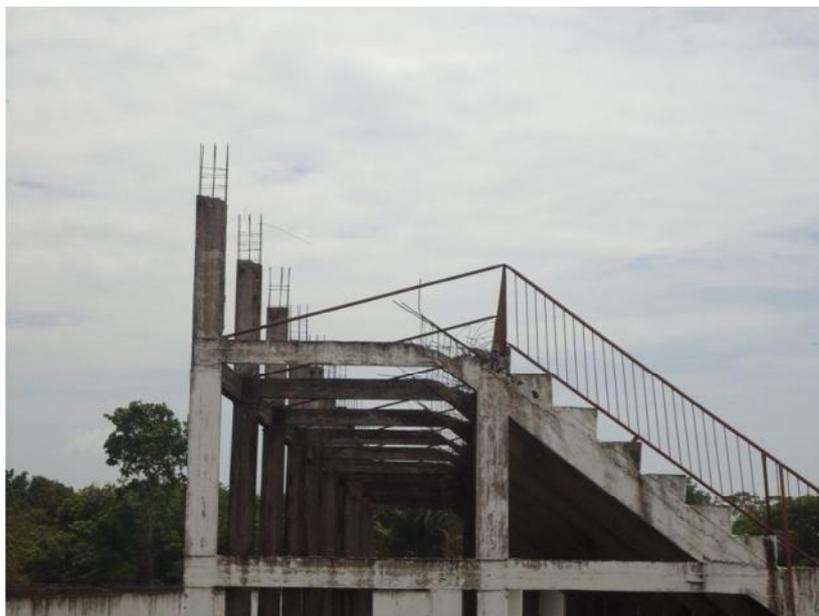
**FIGURA 28:** Parte da arquibancada inacabada do estádio municipal.
