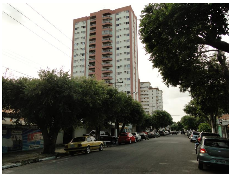
Figura 3.1.5 Imagem do edifício em estudo. Fonte: Autora.
