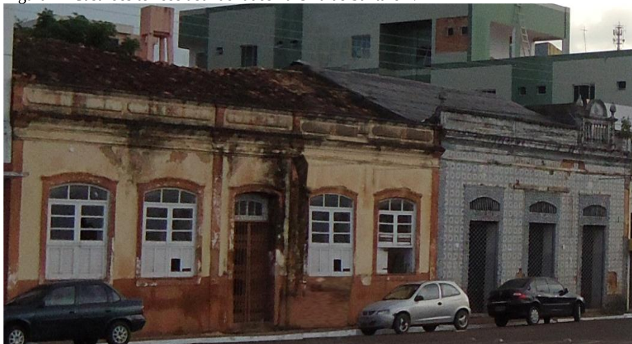
Figura 4– Casarões térreos abandonados na Orla de Santarém.
