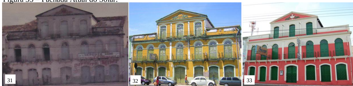
Figura 31 – Pintura da Fachada do Solar década de 1950. Figura 32- Pintura da Fachada na década de 1980. Figura 33 – Fachada Atual do Solar.
