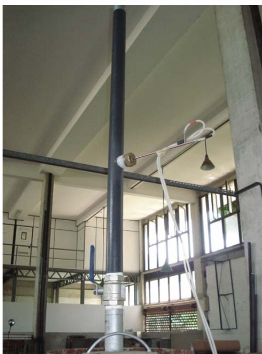
Figura 3.3: Instalação do Pitot no duto de PVC
