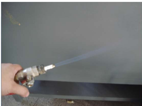
Gás limpo sendo queimado após trem de coleta de gases
