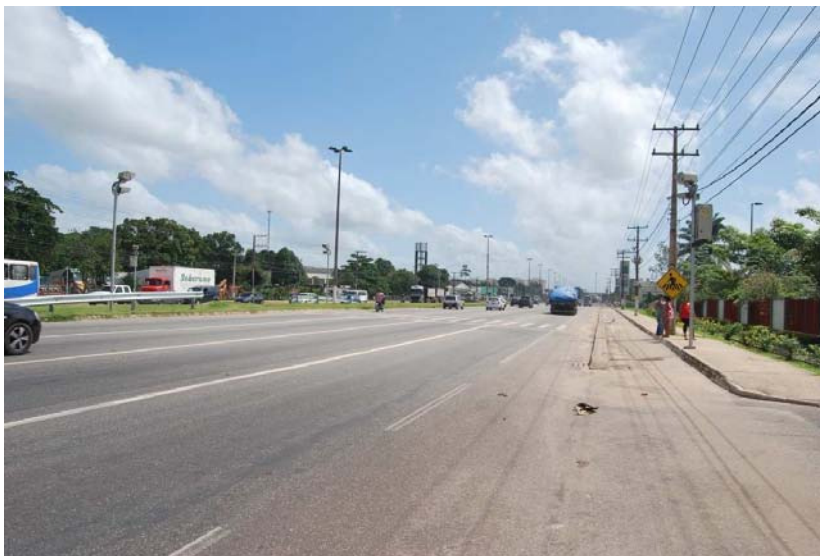
Figura 4.42 Faixa de Pedestre Apagada, Dificuldade de Visualização por Parte do Condutor, BR 316, Km 8, Sentido Crescente, Março/2013.
