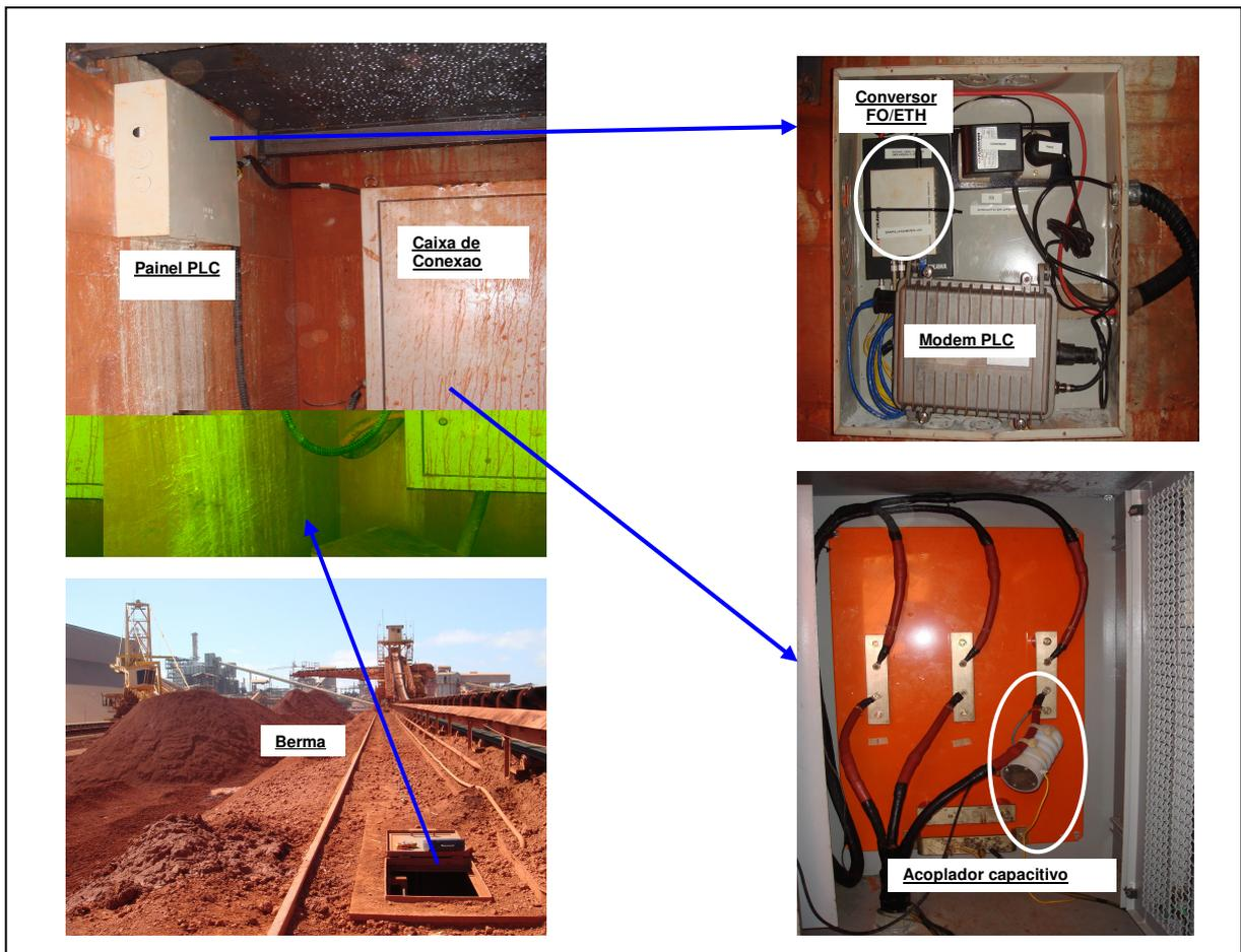
Figura 32: Detalhes do painel PLC e acoplador capacitivo na caixa de conexão
