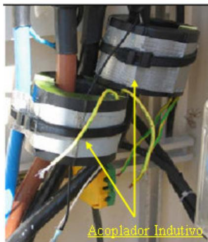
Figura 12: Acoplador Indutivo
