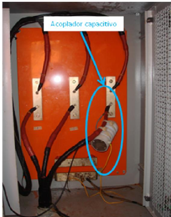
Figura 24: Acoplador capacitivo na caixa de conexão da berma
