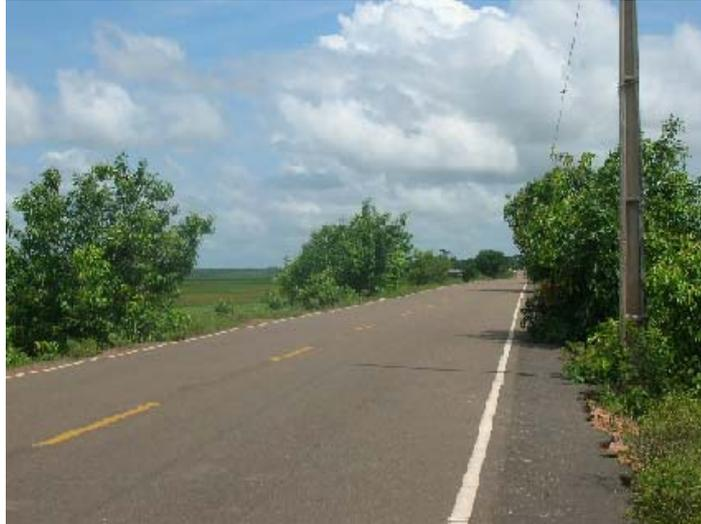
**Fotografia 16: Estrada construída sobre o lago do Curiaú com aproximadamente 1 km de extensão, responsável por impedir o fluxo natural das águas do lago**
