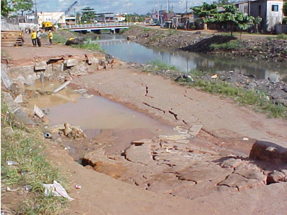
Figura 36: Detalhe da ruptura da Marginal Direita do Canal do Galo (2003)
