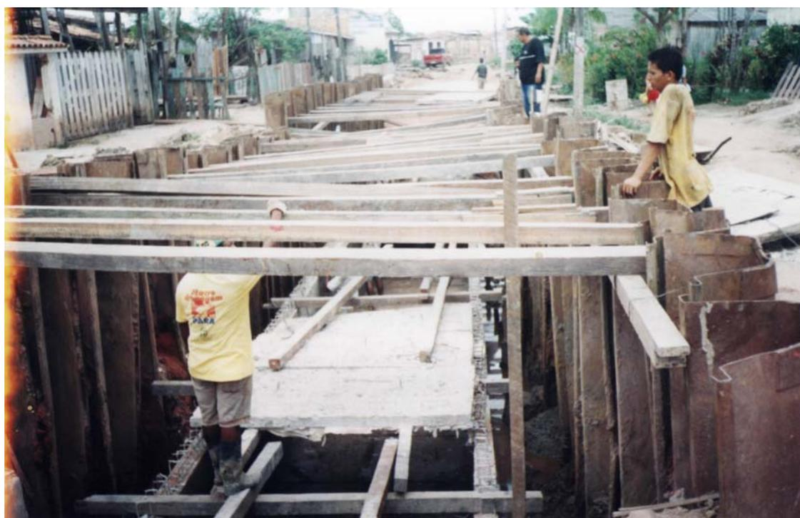
Figura 46: Escoramento metálico de valas em área de solo mole
