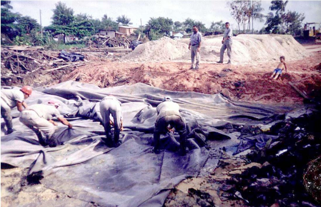
Figura 30: Lançamento de manta geotextil sobre solo natural
