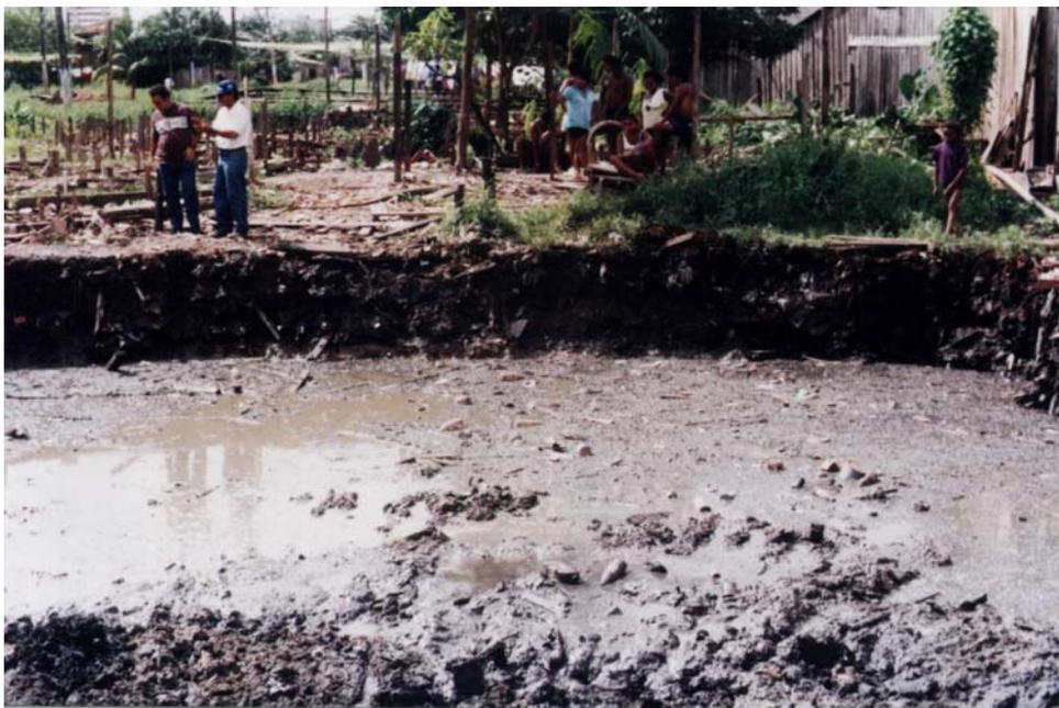
Figura 32: Substituição de material no Canal Antonio Baena em andamento
