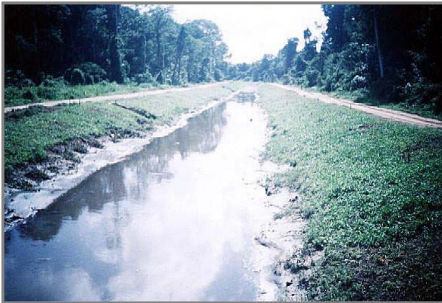
Figura 39: Proteção de talude com revestimento vegetal
