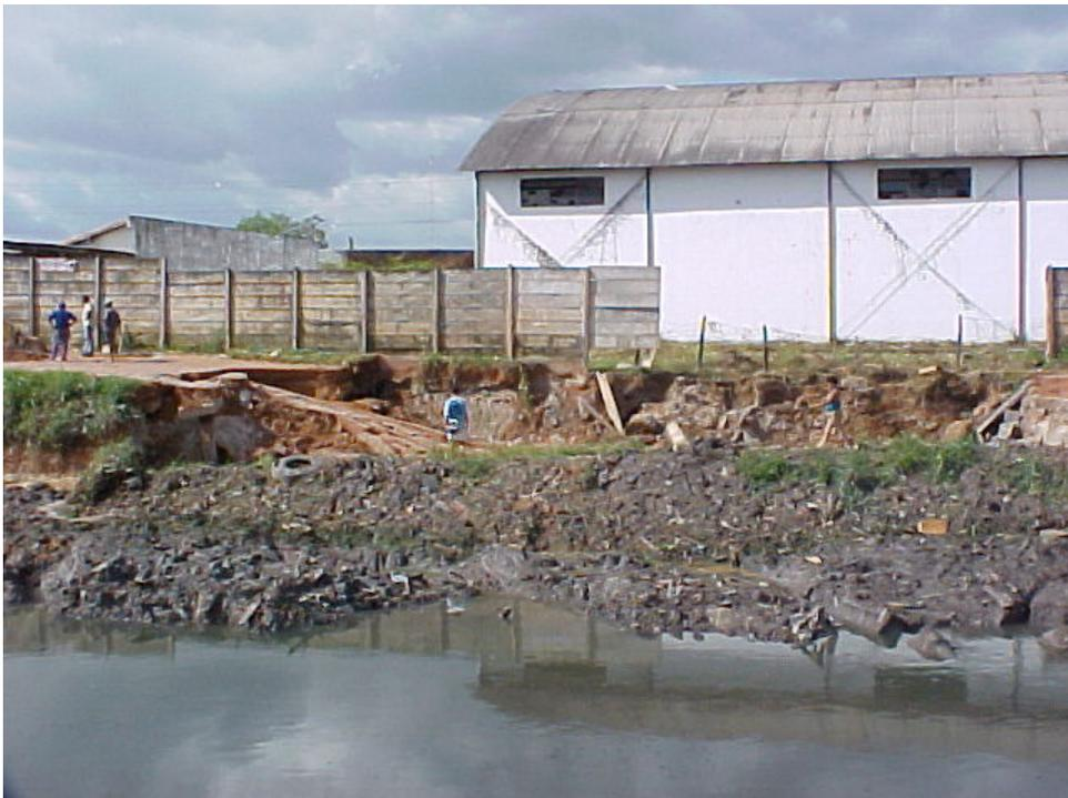
Figura 37: Vista lateral da ruptura na Marginal Direita no Canal do Galo (2003)
