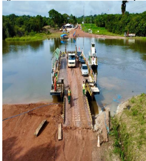
Figura 26 - Local onde será construída a ponte
