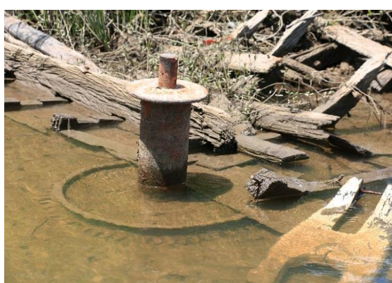
Figura 05 - Equipamento para atracação de barcos
