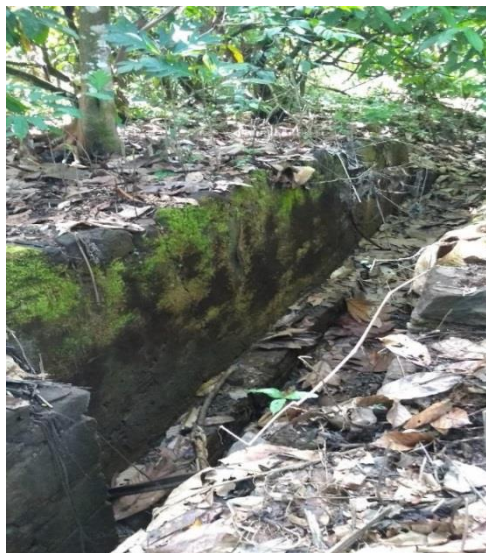
Figura 06 - Canal de escoamento de água do engenho na fazenda Turé
