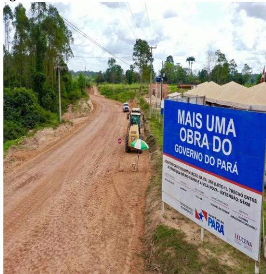
Figura 25 - Placa de asfaltamento da PA 256
