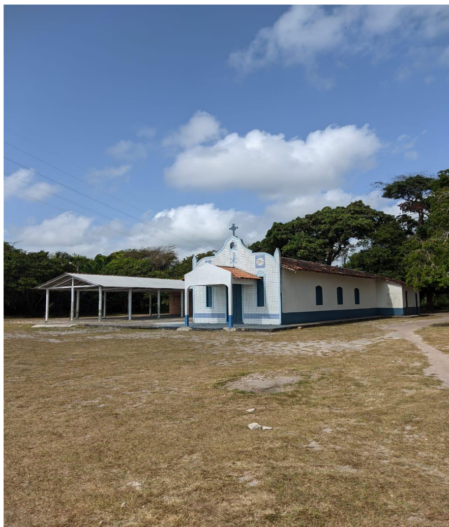
Figura 9 - Igreja de Nossa Senhora do Carmo na beira do rio Paracauari.
