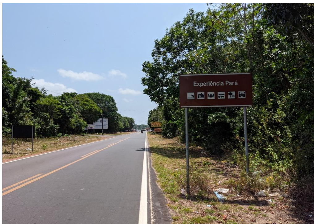
Figura 14 - A rodovia PA-154 no sentido em direção ao Porto da Balsa, próxima à entrada do Caldeirão.
