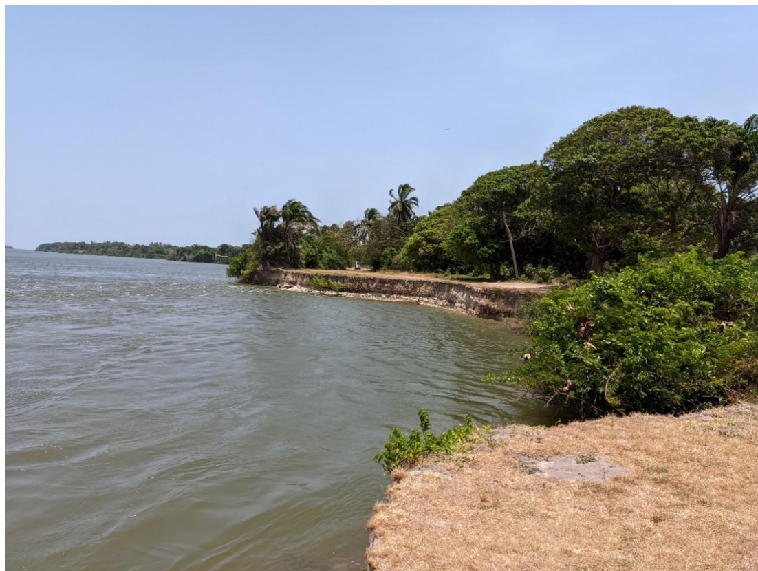
Figura 27 - Rio Paracauri e em sua beirada, suas marcas da erosão.
