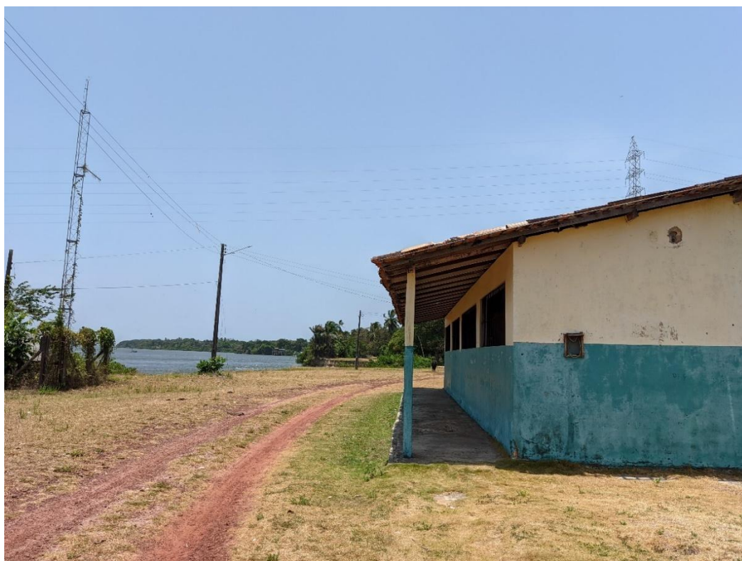
Figura 20 - Sede Principal da Escola Sebastião de Assis Gonçalves na beira do rio Paracauari.
