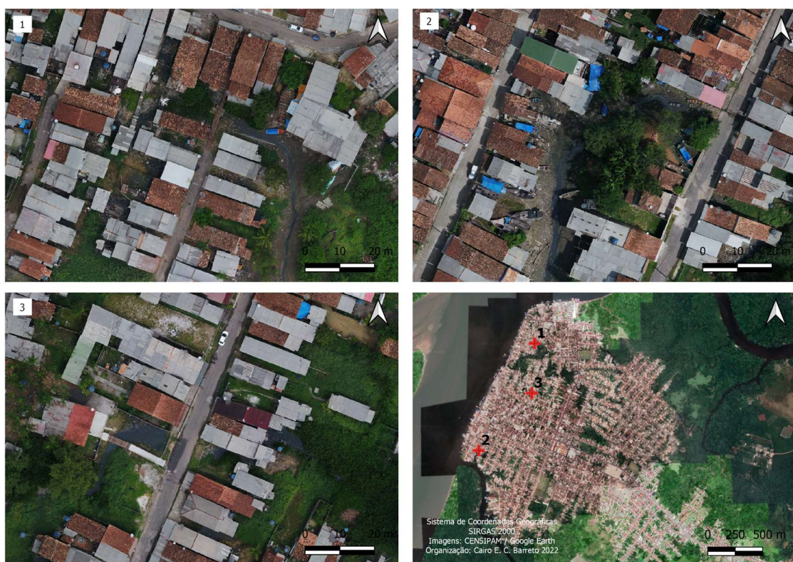
Figura 20 – Ocupações no leito do rio.
