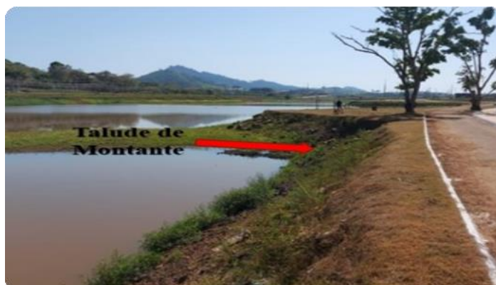
Anexo 01: Talude de montante
