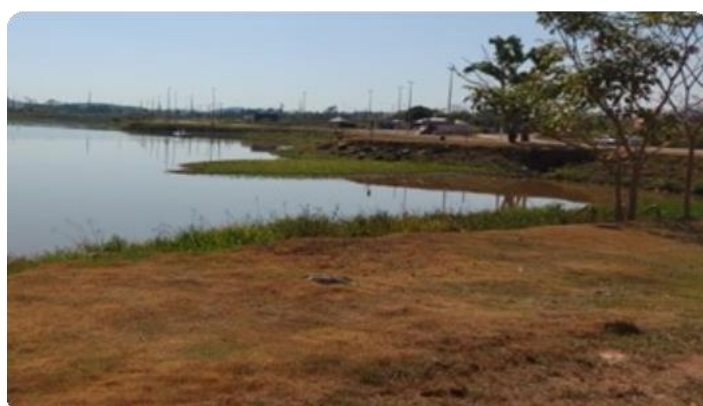
Anexo 03: Talude de Jusante
