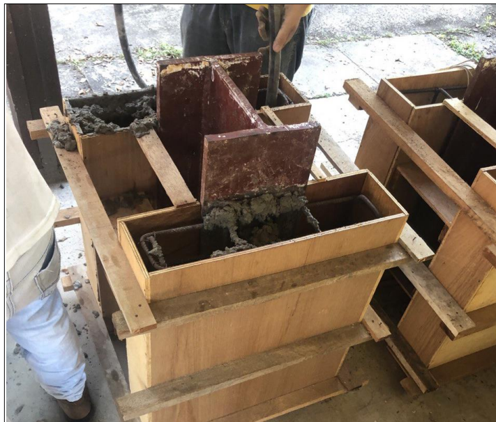
Figura 3.16 - Adensamento do Concreto lançado
