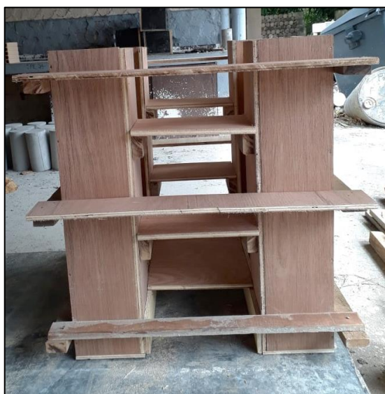
Figura 3.15 - Fôrma de madeira pronta para concretagem
