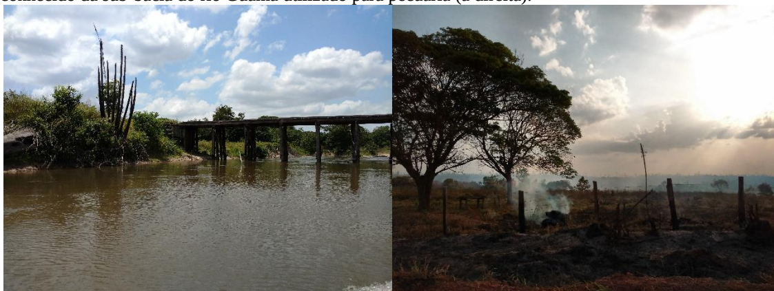
Figura A9 – Ponte sobre o rio Guamá nas proximidades da comunidade Arauaí (à esquerda) e trecho desconhecido da sub-bacia do rio Guamá utilizado para pecuária (à direita).
