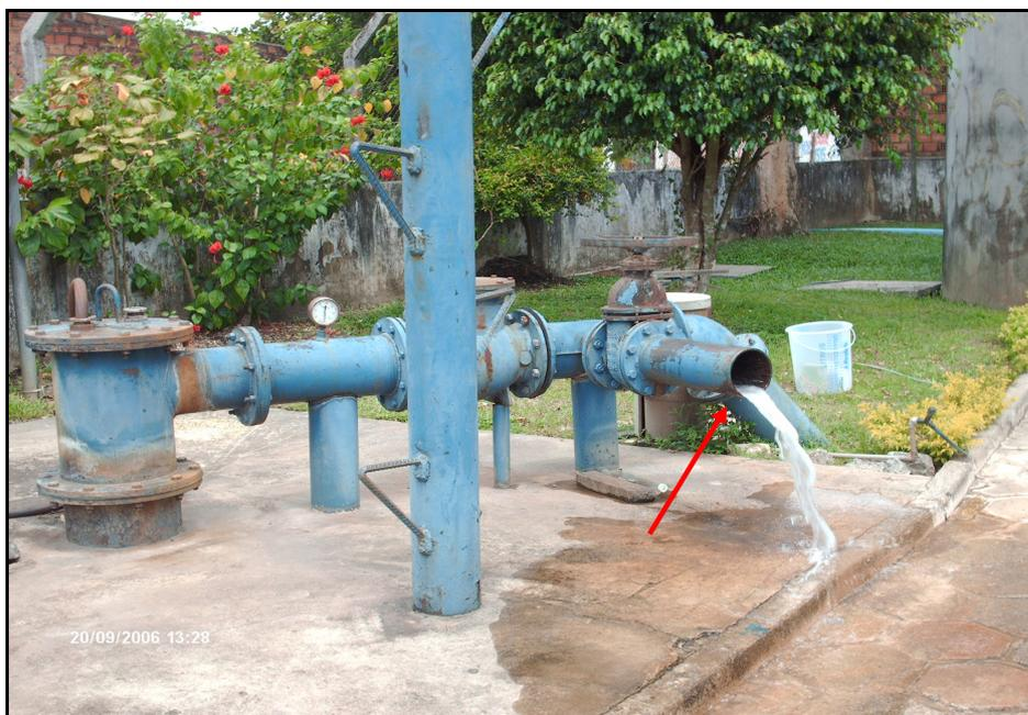
Figura 14: Fotografia ilustrando o sistema de válvulas pelo qual as amostras de água do poço foram coletadas. Local de coleta da amostra da unidade Tocantins.
