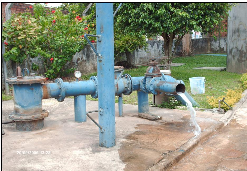
Figura 11: Unidade Tocantins captação de água subterrânea pertencente à prefeitura de Belém (SAAEB).
