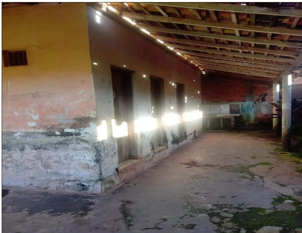
Figura 7 - Corredor de acesso aos banheiros da escola.
