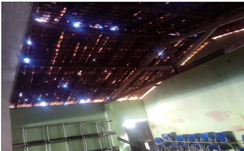
Figura 6 - Telhado da escola.
