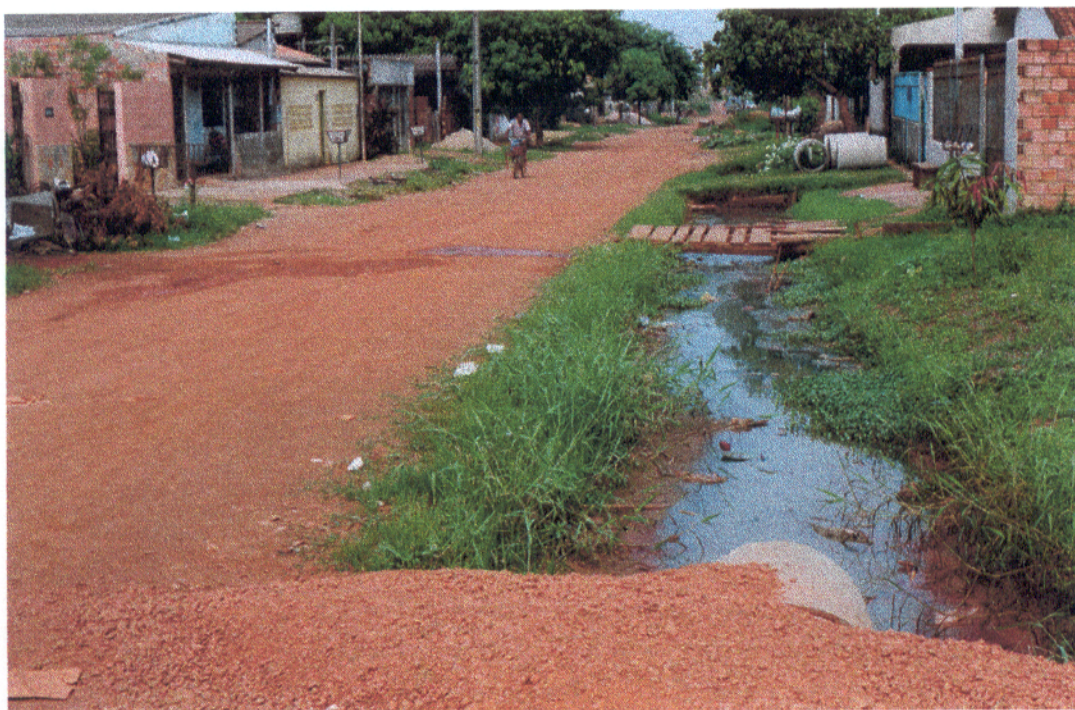
Figura 8 - Drenagem de esgotos domésticos a céu aberto, em Porto Velho - RO. Observe-se o tipo de solo, favorável à rápida infiltração
