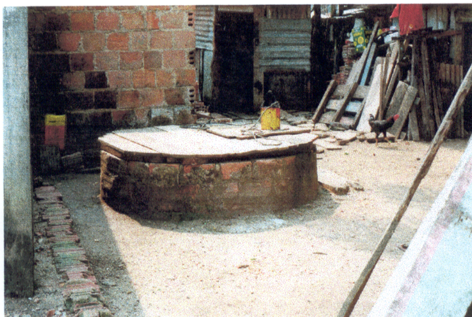
Figura 14 - Poço escavado tipo “amazonas” com 11 m (OLA37). Apresenta más condições higiênicas, não tem revestimento interno e nem bomba. O solo é areno-argiloso, fossa a 5 m. Zona urbana de Porto Velho - RO.
