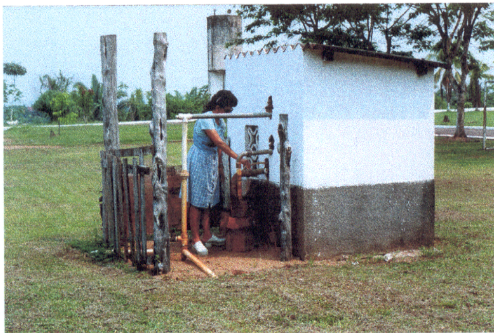
Figura 13 - Poço tubular com 42 m (NAC16). Apresenta boas condições higiênicas. Solo laterítico, o teor de ferro total é da ordem de 2,4 ppm. Zona urbana de Porto Velho - RO.
