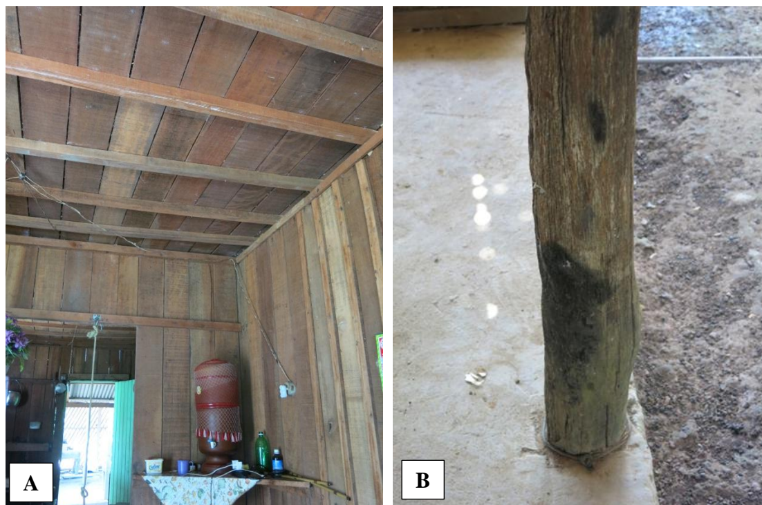
Figura 28 - A) Telhado de tábua. B) Esteio de Acapu com marcas de fogo tirado na região reservatório.
