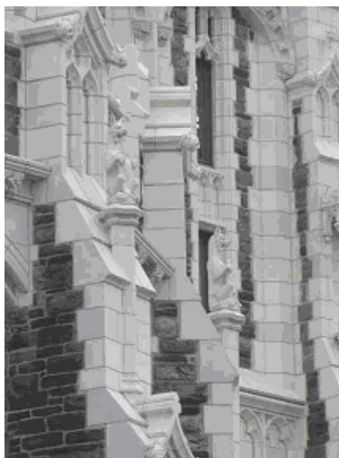
Figura 55. Peças pré-fabricadas de GRFC confeccionadas com a incorporação do MCAR Fonte: Crusid (2003)
