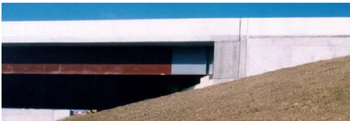
Figura 52. Guarda-corpos fabricados com concreto de cimento Portland branco e MCAR de modo a aumentar a reflectância da luz durante neblinas e o período noturno. Fonte: Engelhard Corporation (2007)
