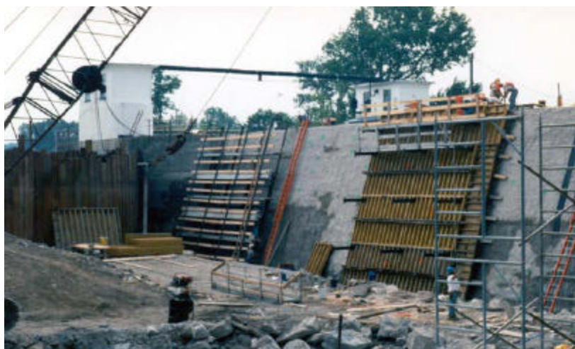
Figura 56. Aplicação do concreto com MCAR para revestir o canal Eire, Nova York. Fonte: Engelhard Corporation (2007)
