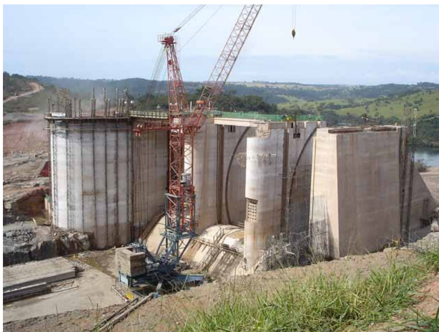
Figura 57. Usina Hidrelétrica de Capim Branco I. Fonte: Rocha (2005)
