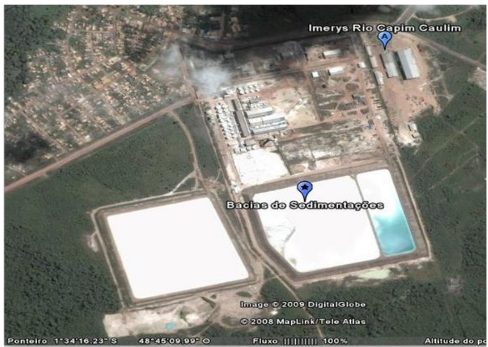
Figura 3. 9: Lagoa de sedimentação da IRCC (Fonte: Imerys 2009 apud Santos 2011)
