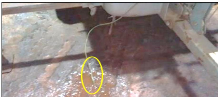
Figura 3.2 - Aterramento de torre de iluminação.
