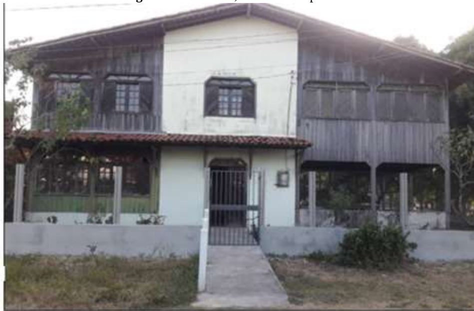
Figura 12 – Mureta, alambrado e portão
