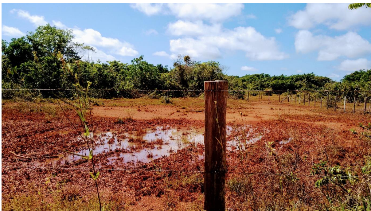
Fotografia 19 – Área degradada na área de lotes individuais
