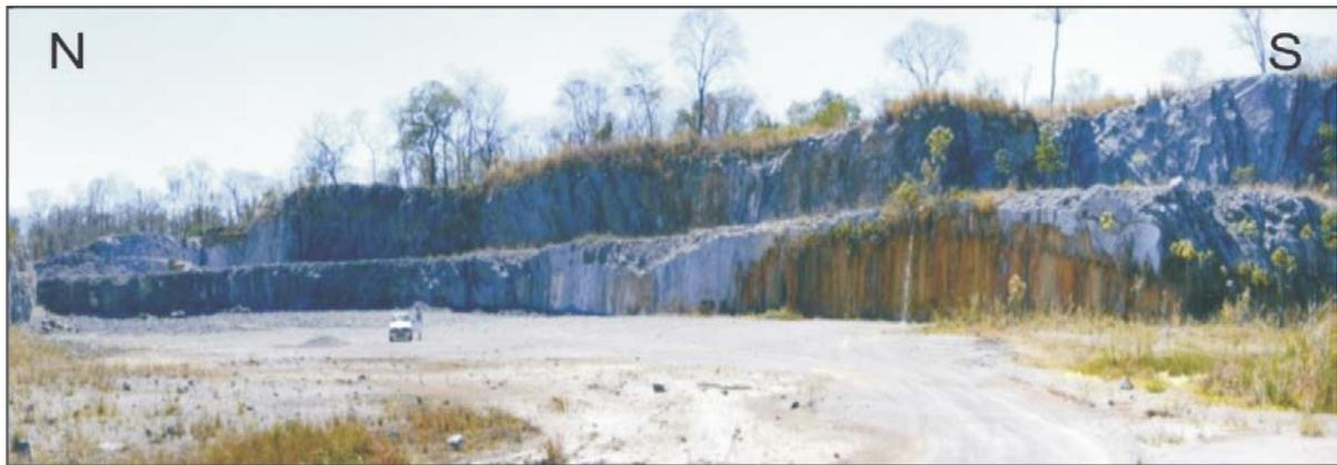
Figura 50- Mina 2, com aproximadamente 200 m de comprimento e 14 m de altura, cuja rocha dominante é o calcário fino.
