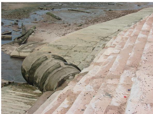
Figura 35 – Muro em sacos de solo-cimento.
