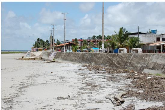
Figura 51 – Rampa 1 apresentando solapamento e acentuado desnível próximo a sua base. Marudá, maio de 2009.
