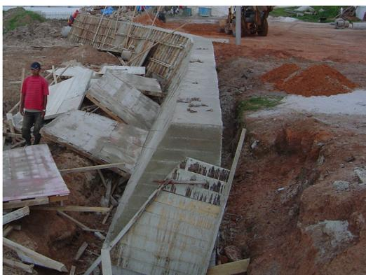
Figura 31 – Muro de concreto ciclópico. Marudá (PA), julho de 2004.
