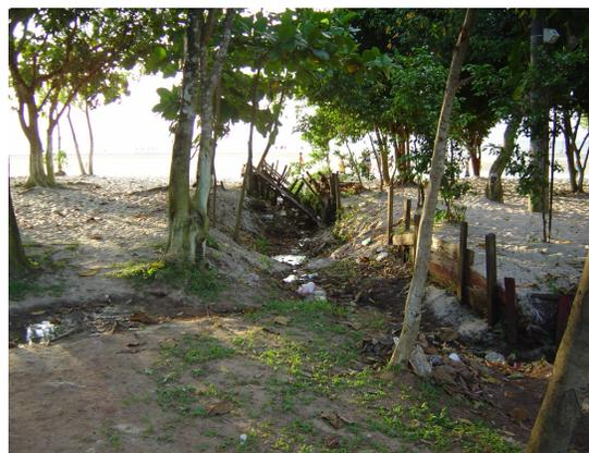
Figura 86 – Erosão do solo devido à drenagem superficial. Praia do Amor, Outeiro (PA), setembro de 2004.
