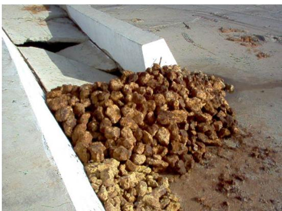
Figura 47 – Tentativa de contenção do solapamento na base das rampas com pedras. Marudá, julho de 2004
