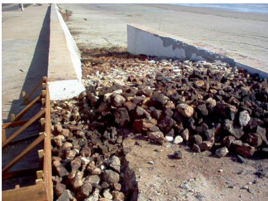
Figura 49 - Solução de enchimento de pedras no corpo da rampa. Marudá, julho de 2004.
