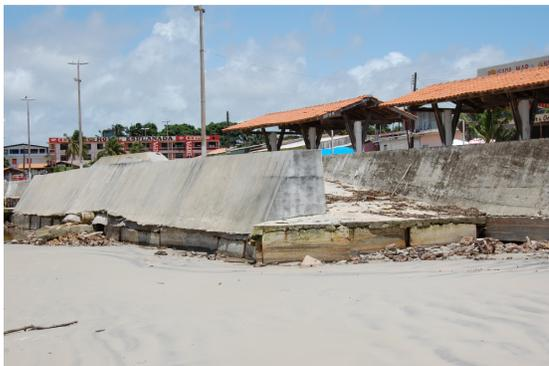
Figura 53 – Base da Rampa 1, apresentando solapamento em sua base com suas fundações aparentes. Aparecimento de vãos na estrutura. Marudá, maio de 2009.
