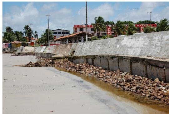
Figura 54 – Tentativa de contenção do solapamento da base do muro com pedras. Marudá, maio de 2009.
