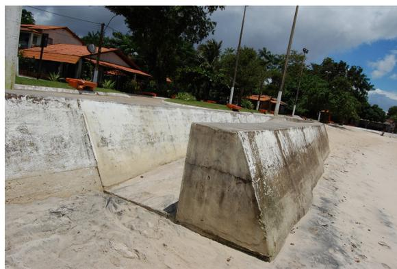
Figura 32 – Muro de concreto ciclópico. Outeiro (PA), maio de 2009.
