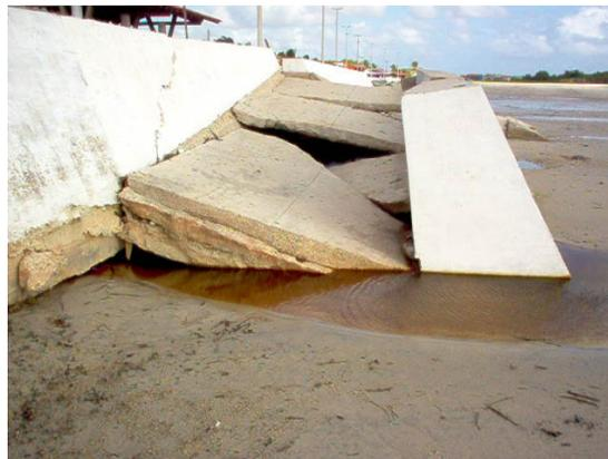
Figura 46 – Rampa 1 destruída. Acúmulo de água denunciando o solapamento em sua base. Marudá, julho de 2004.
