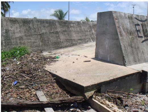
Figura 61 – Situação atual da base da Nova Rampa. Deposição de lixo e solapamento da areia sob a rampa. Acentuado desnível. Marudá, abril de 2009.
