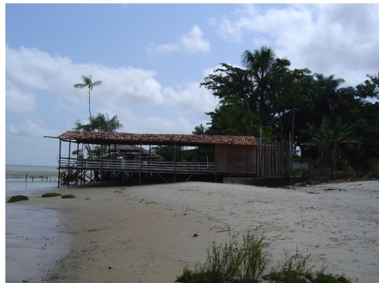
Figura 92 – Edificação sobre a zona de espraiamento das ondas. Perigo de colapso. Praia do Amor, Outeiro (PA), setembro de 2004.
