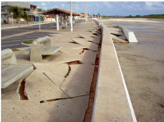
Figura 45 – Calçada afetada pelo colapso do paramento. Marudá, julho de 2004.
