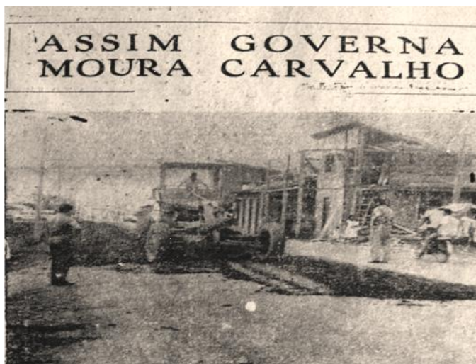
Fotografia 8 - Serviço de asfaltamento da Estrada Nova.
