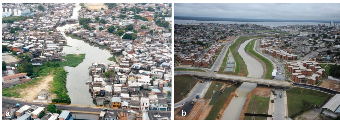
Figura 40a-b - Igarapé Quarenta antes e depois da intervenção de saneamento.
