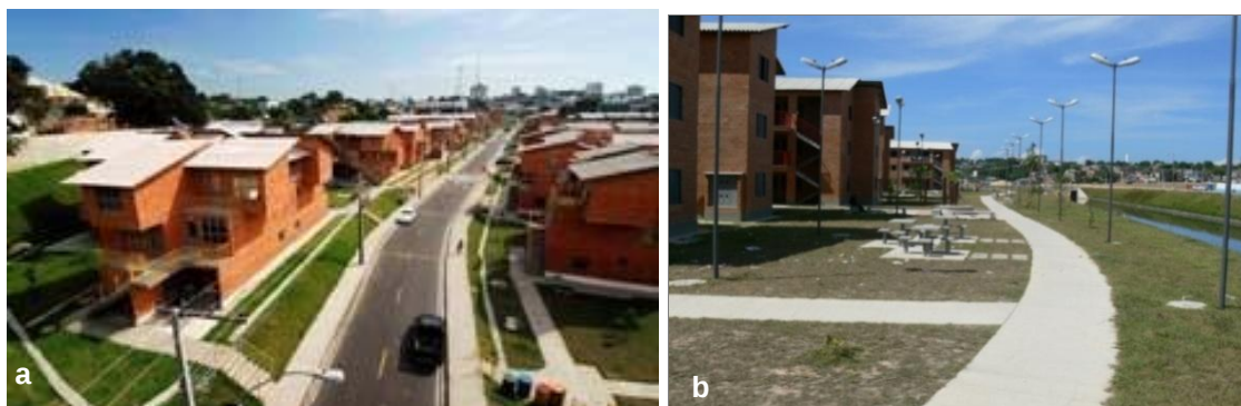
Figura 37a-d - Parque Residencial Manaus, construído em cima de uma parte do Igarapé Manaus. Por baixo da Avenida foram instaladas galerias que ligam a rede de esgoto geral, pronta para receber a rede intradomiciliar.
