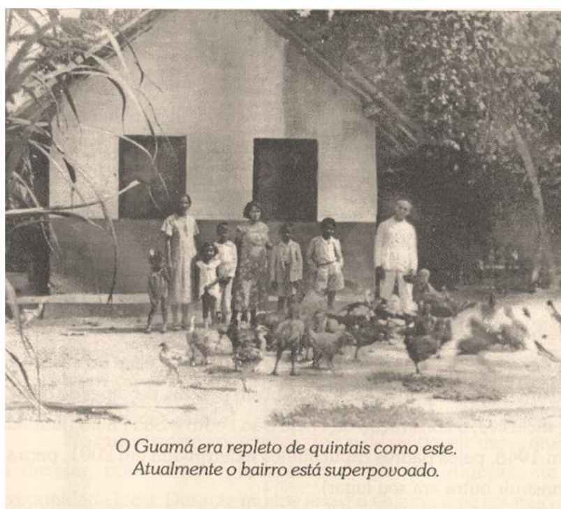
Fotografia 5 - Aspecto da moradia no bairro do Guamá (início do Século XX).
