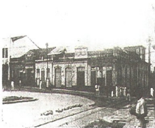
Figura 47: Casas demolidas Fonte: NASCIMENTO, 2004. 153
