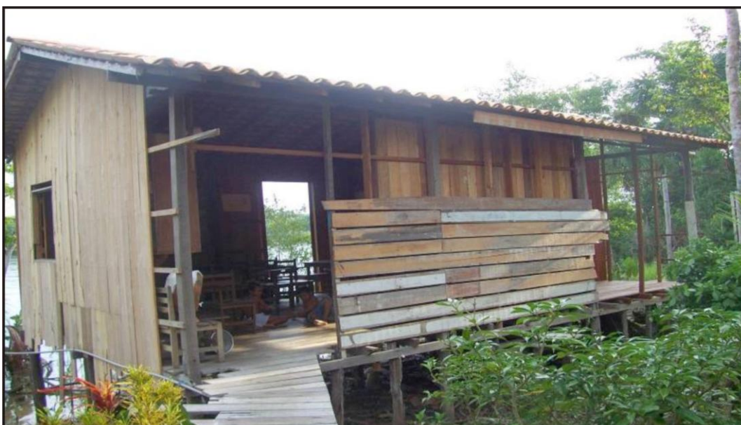
Foto 18: Fachada de trás do novo prédio escolar. Fonte: Maria do Socorro Dias Pinheiro, dezembro de 2008.
