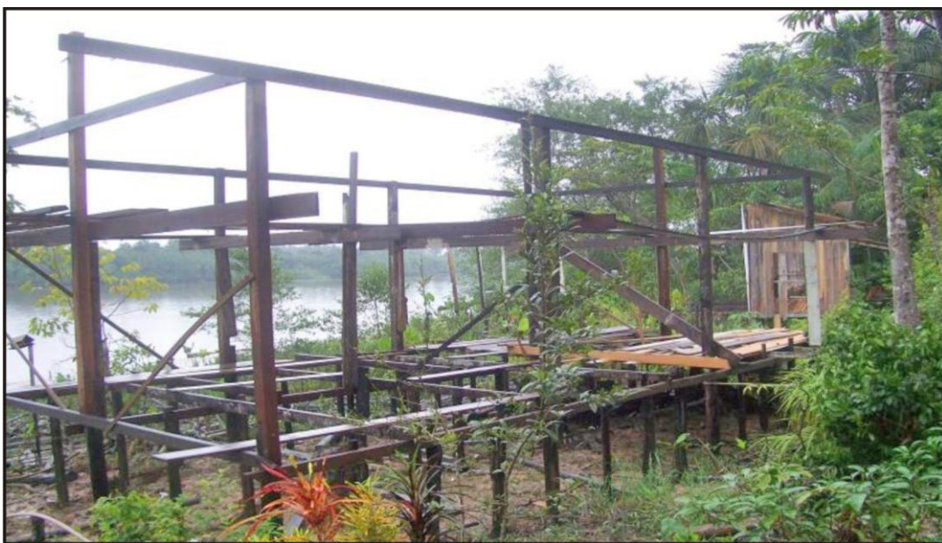
Foto 12: Prédio escolar em construção. Fonte: Maria do Socorro D. Pinheiro, abril de 2008.
