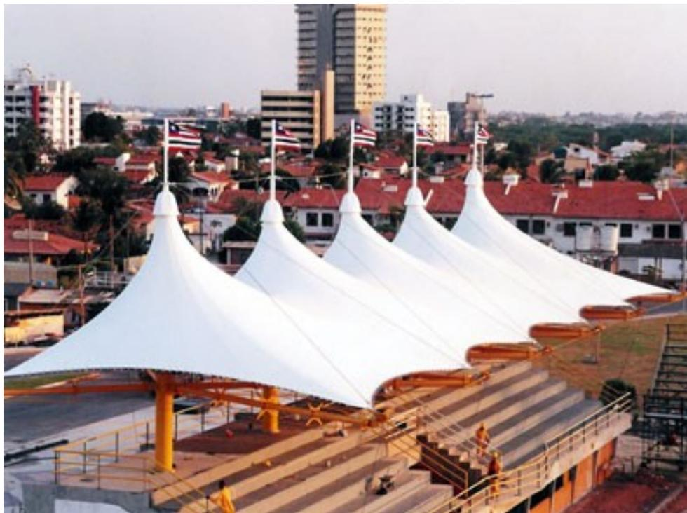
**Figura 2.27 - Tensoestrutura de 680m<sup>2</sup> na Lagoa de Jansen em S. Luiz (MA).** Fonte: ARCOWEB (2002).
