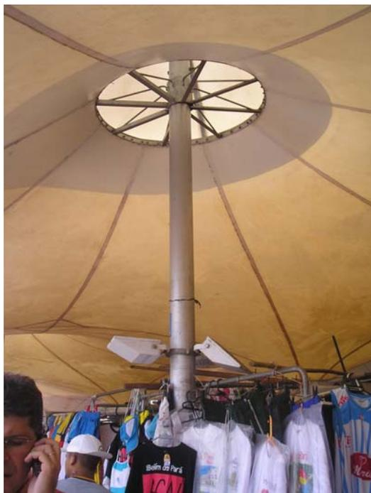
**Figura 5.6 – Respiradouro localizado nos pilares centrais (foto datada de 09/11/2005).**
