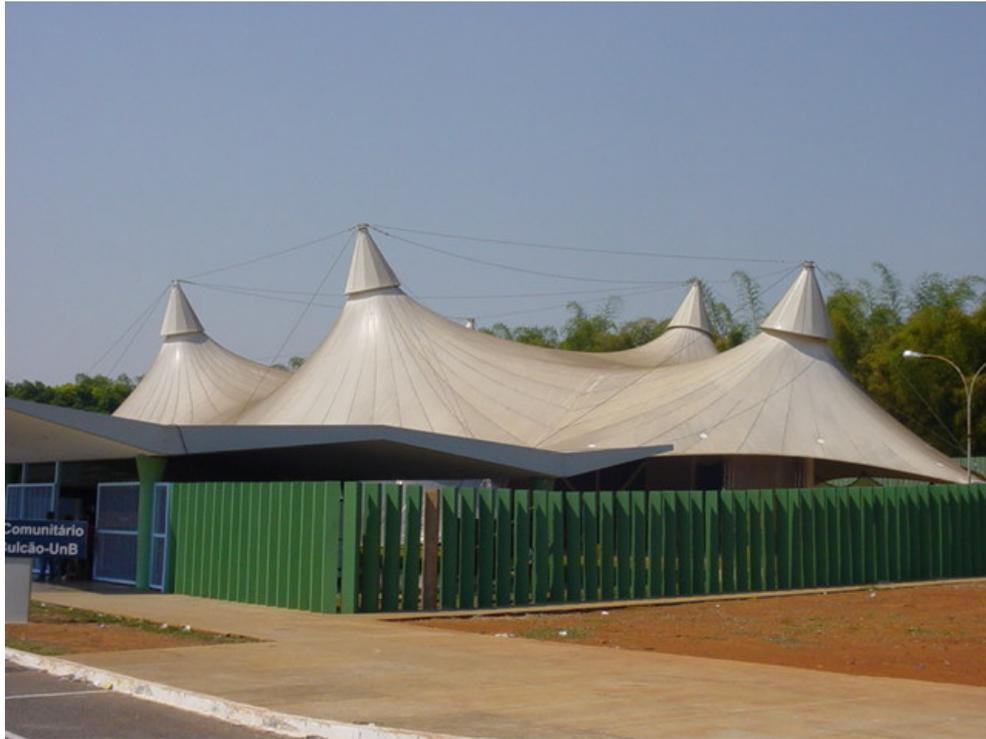
**Figura 2.26- Tensoestrutura UnB-DF (26/09/2003).** Cortesia: Prof. Dênio Raman.
