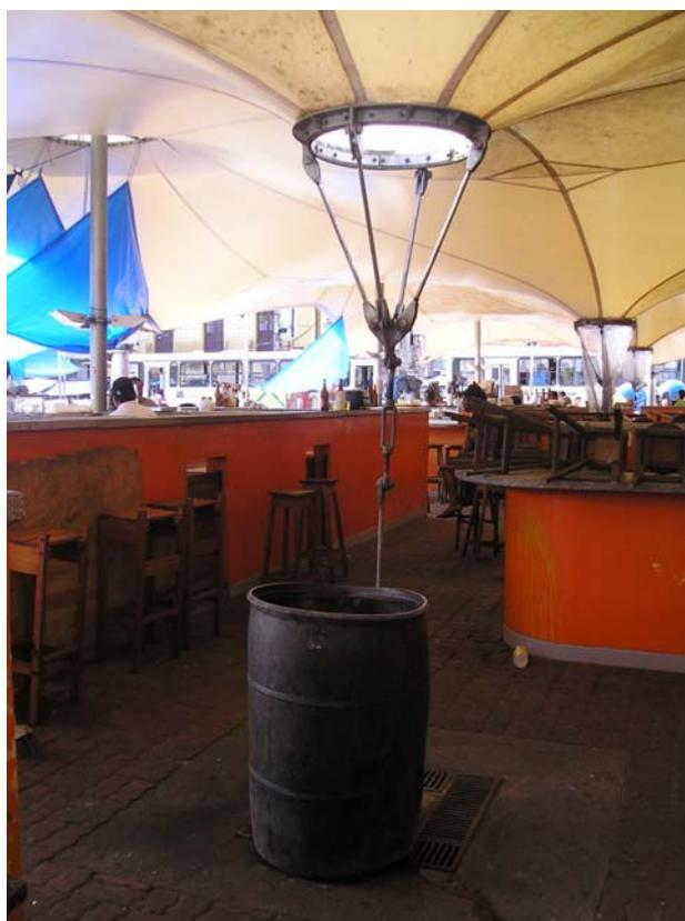
**Figura 5.12 - Colocação de um tambor, pelos feirantes, na abertura existente na cobertura para descida da água das chuvas (foto datada de 01/05/ 2005).**
