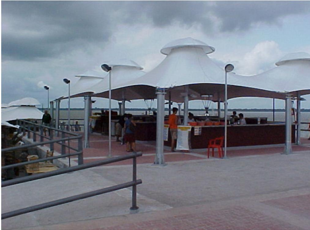
**Figura 5.3 – Tensoestruturas utilizadas na reforma do Ver-O-Peso.**
