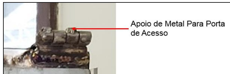
Figura 64 - Apoios de metal para sustentação da porta de acesso
