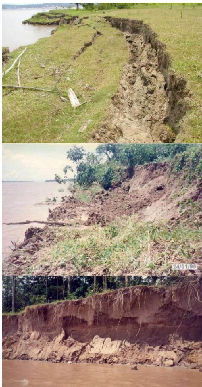
Figura 2- O processo de terras caídas.
