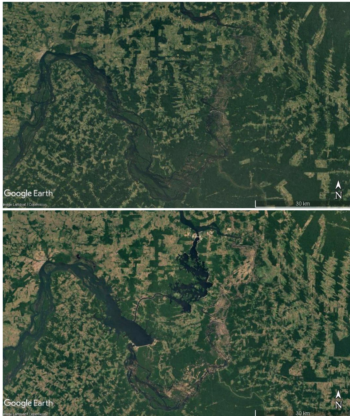
Figura 2 – Composição de imagens – Impactos da construção da UHE Belo Monte, visão ampliada da Volta Grande do Xingu que mostra região alagada, imagem superior, ano 2006, antes da instalação da Hidrelétrica, imagem inferior, ano 2020, após a instalação da Hidrelétrica.
