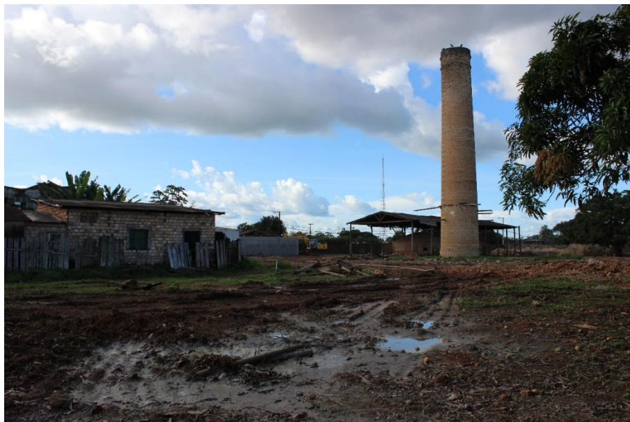
Figura 12 – Foto – Terreno da antiga olaria onde foi construída a Casa de Memória Transxingu em Altamira/PA.
