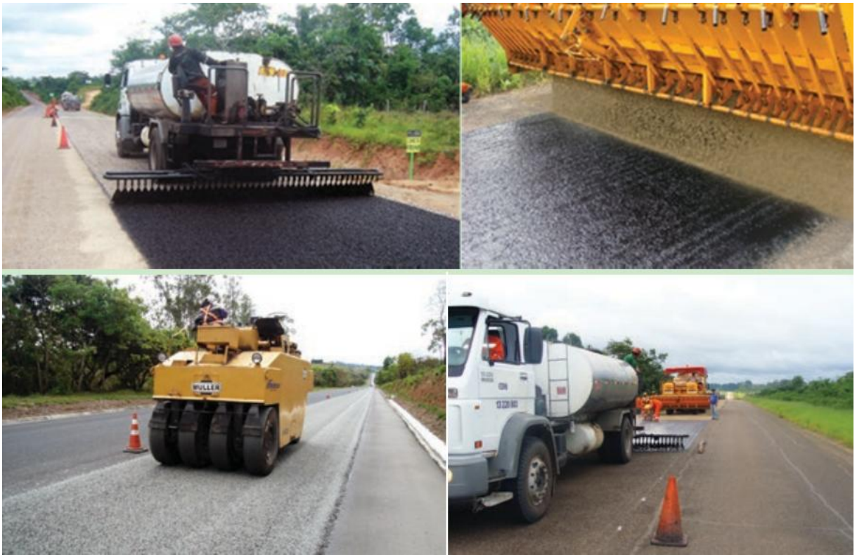
Figura 15: Espargidor aplicando o ligante asfáltico, para posterior aplicação do agregado e compactação do revestimento [5].
