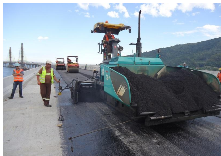
Figura 13: Aplicação da mistura quente para construção do revestimento asfáltico [6].
