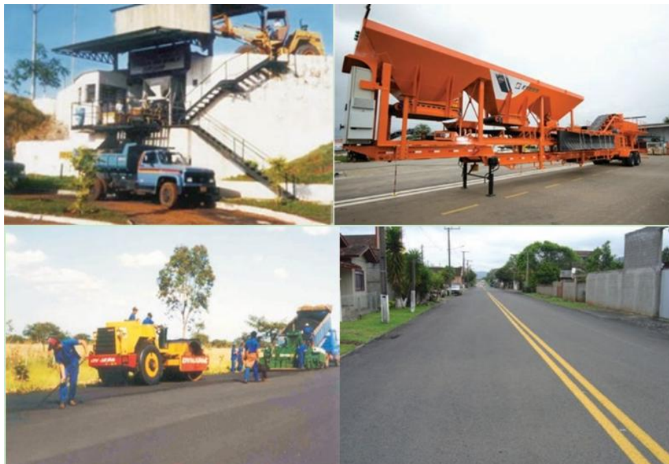
Figura 16: Usina de PMF fixa e móvel e a aplicação do mesmo em um pavimento flexível [5].
