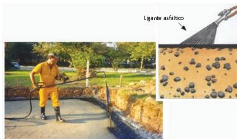
Figura 11: Pintura de ligação realizada com a caneta espargidora [5].
