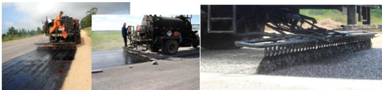
Figura 10: Aplicação da pintura de ligação [5]
