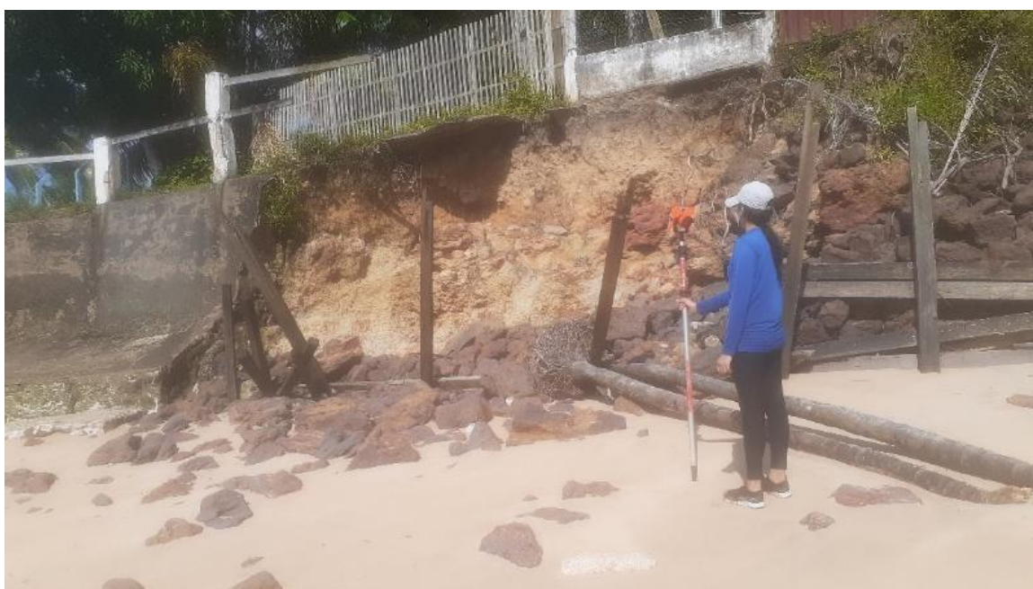
Figura 24. Construção de barreiras criadas pelo morador local. Fonte: Autor.
