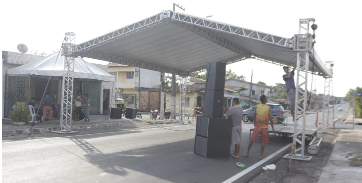
Fotografia 22 – Imagem da estrutura montada em frente à residência de Mestre Vieira no ano de 2019.
