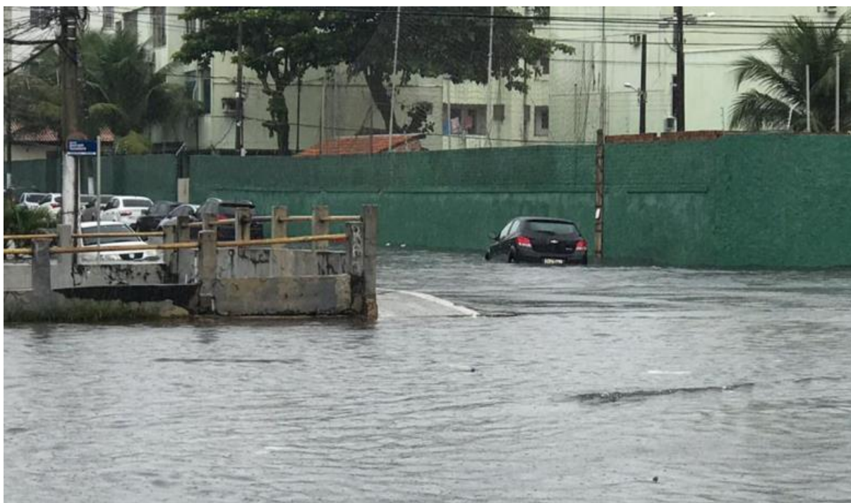
Figura 1 – Avenida Almirante Tamandaré alagada após temporal.
