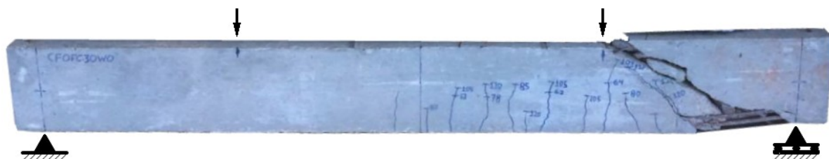
Figura 7.1 – Viga CF0W0 (ruptura por cisalhamento).
