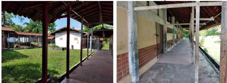
Figura 17 – Bloco de salas à esquerda
