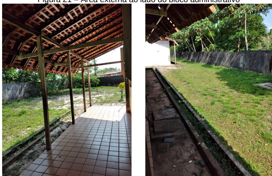
Figura 21 – Área externa ao lado do bloco administrativo
