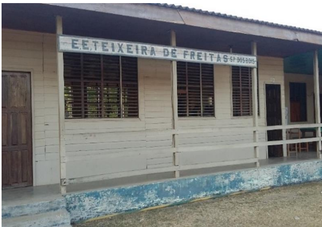
Figura 09: Terceiro prédio da Escola Teixeira de Freitas
