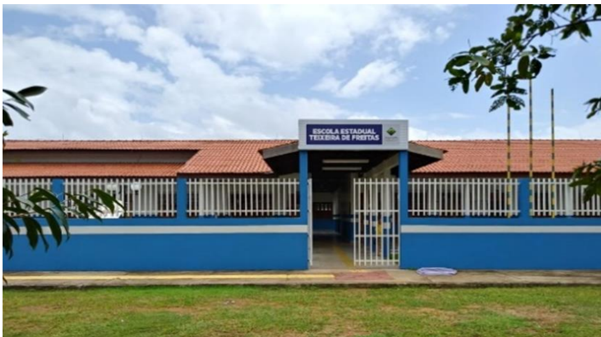
Figura 10: Atual prédio da E.Q.E Teixeira de Freitas
