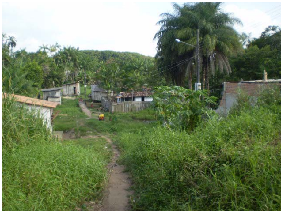
Figura 78– Vista do final da Passagem Cônego Luís Leitão no bairro Cariri, onde se vê um desnível de cerca de 10 m. Note-se o muro de arrimo à direita (julho/2007).
