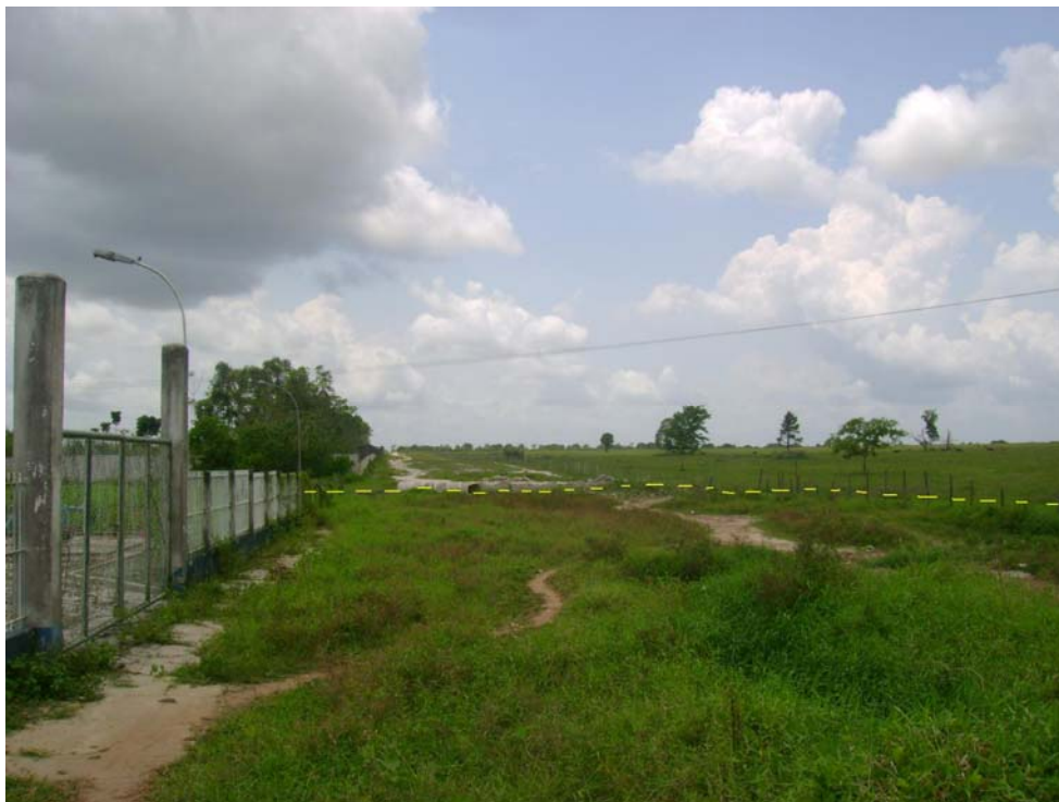
Figura 69 – Frente da área de captação da COSANPA no bairro Milagres, situada na Avenida José Bertino da Silva, com o igarapé do Quatro em segundo plano. Note-se ao fundo tubulões de concreto para futuro saneamento do referido igarapé (julho/2007).
