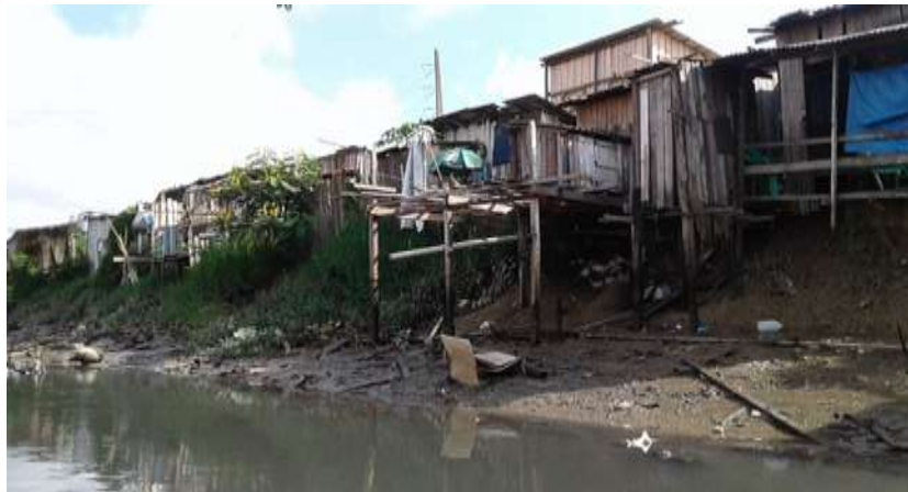
Figura 16- Ocupações desordenadas às margens da bacia.
