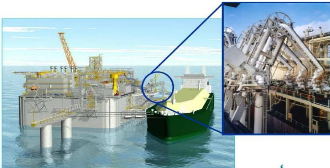
Figura 4.2 - Terminal de concreto flutuante (do tipo GBS).
