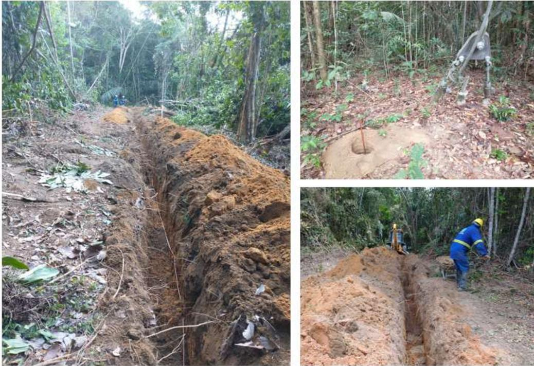
Figura 4.15 - Instalação de cabos e hastes de aterramento, terra gel.
