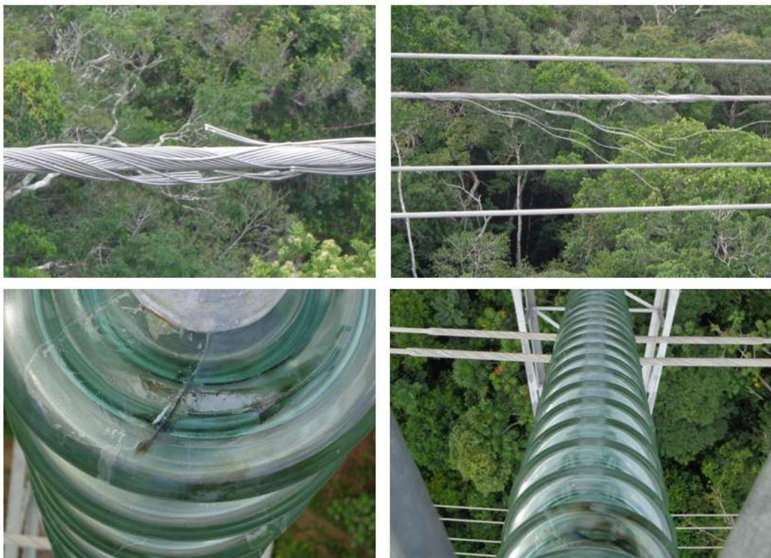
Figura 2.5 - Danos causados por descargas atmosféricas na LT Oriximiná – Silves CD.
