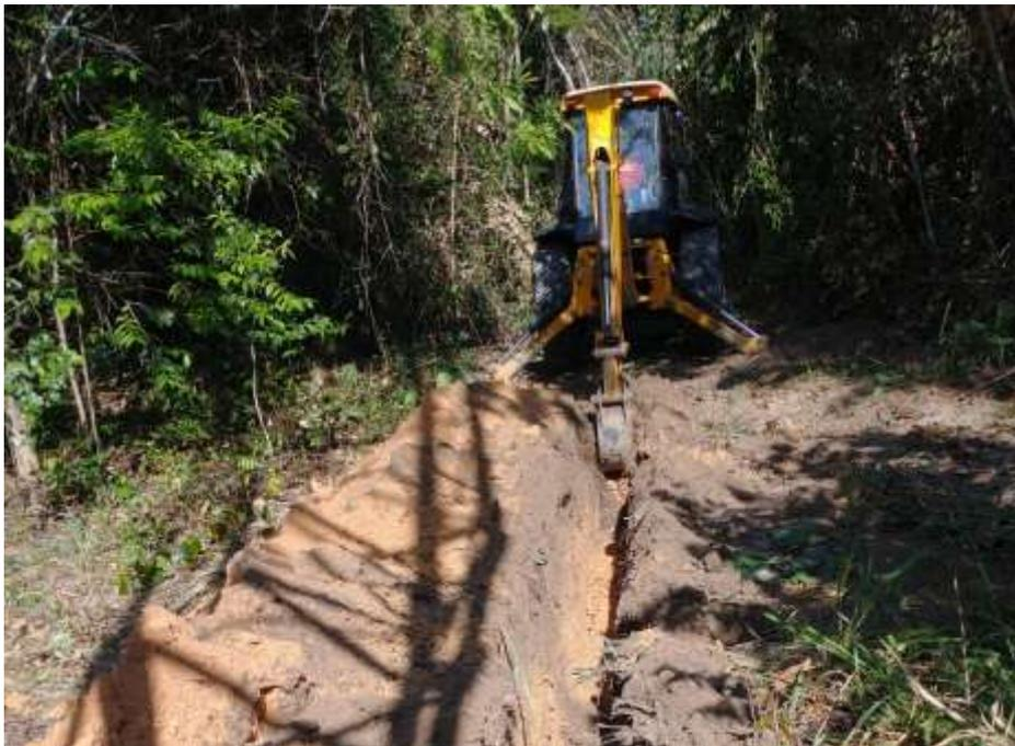
Figura 4.14 - Abertura das valas para implementação de cabos de aterramento.
